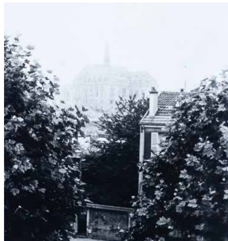
Vue sur l'hôtel de ville, 17, bd de la Commune-de-Paris, 1981. « Premier regard à travers la brume. J'étais amoureuse de cette vue. Je surveillais les travaux de construction de la ZAC Basilique. »
