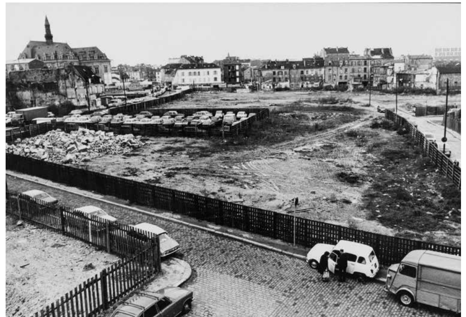
Chantier de la ZAC Basilique, centre-ville en cours de démolition, fin des années 1970.
